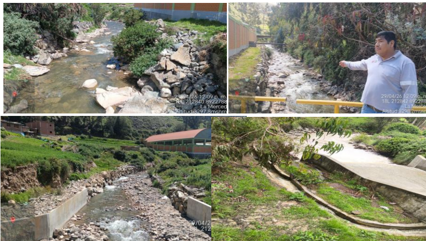
Imagen 3.- Se observa el colegio Vicente Guerrero Palacios en la ribera, expuesto a peligro de erosión [lateral] a caudales de máximas avenidas.
