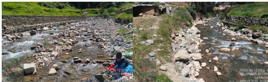
Imagen 1.- Se observa la colmatación de cauce (bolonerías), generando riesgo de inundación.
